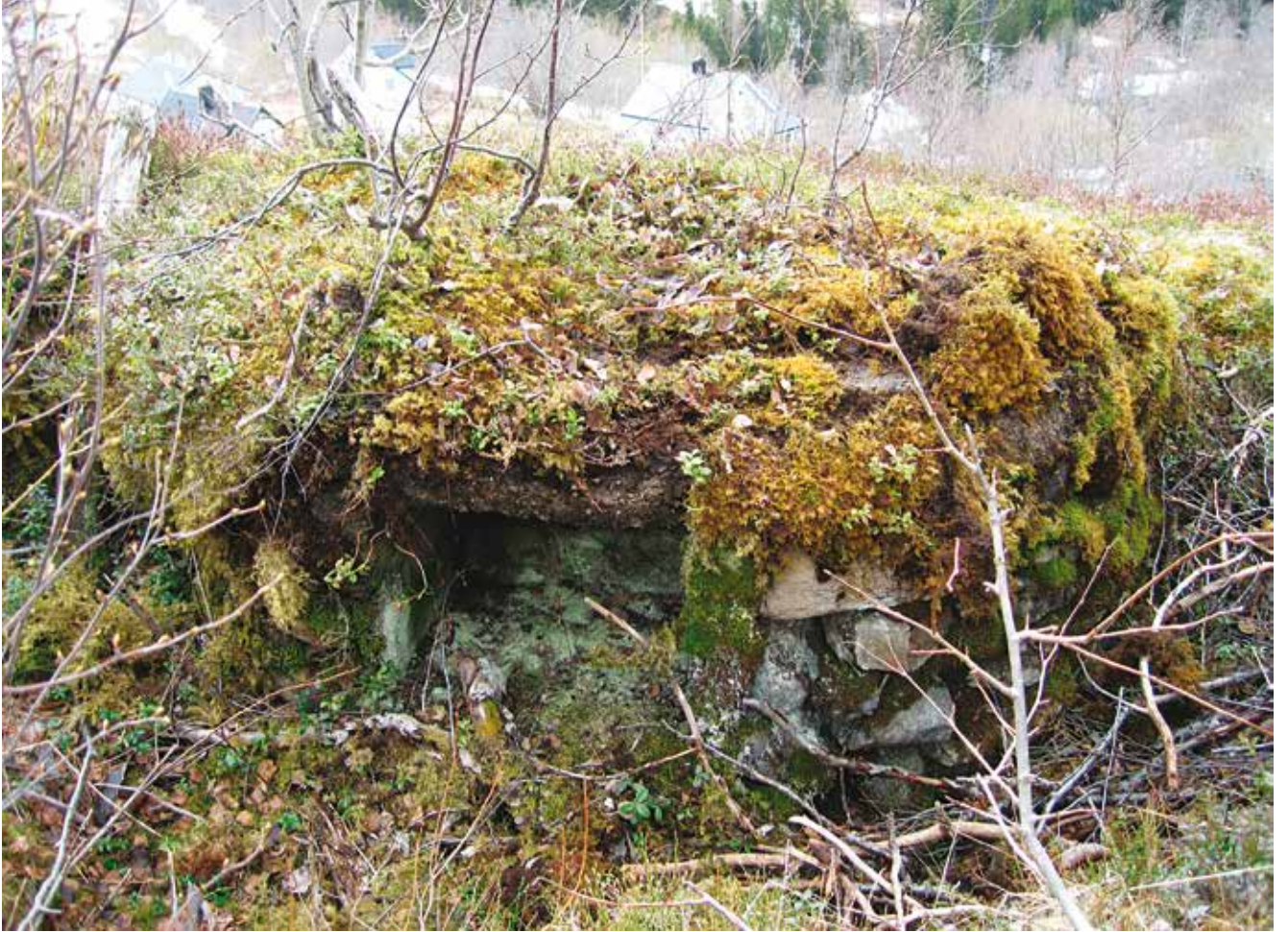
Fundament for tidligere norsk feltkanon, 7,5 cm, samme sted. Foto: T.G. Merk at boken "Der Atlantikwall" av Rudi Rolf oppgir at det er to 7,5 cm (norske) i Røsvik og fire belgiske 7,5 cm. Tilhørende dekningsbunker for kanonmannskapene til disse to kanonene, må være den som ligger i samme område. Jfr. bilde side 19.
