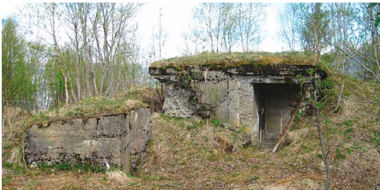
Tysk dekningsbunker i Nes. Dette var kommandobunkeren. I følge Erling Olsen jr. var det før glass i skyteskåråpningene på denne bunkeren. Til venstre for bunkeren ser man den ene av to nedganger til tunellsystemet i fjellet. Disse nedgangene har tidligere hatt tretrapper. Som de står nå, skulle de vært sikret for unger. Like ved denne bunkeren ligger restene av en bunker til, en ganske stor en. Det er en kombinert deknings- og beboelsesbunker for mannskapene til to av tre luftvernstillinger like ved. FOTO: TG.
