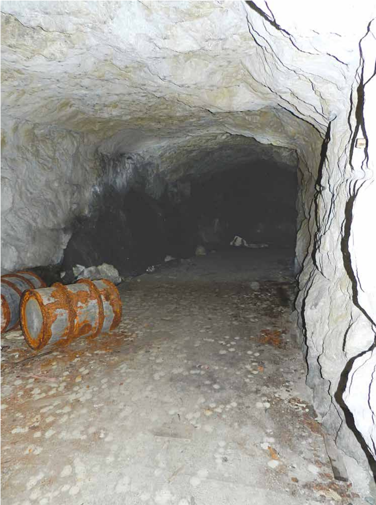
Ditto tunnel i Nes. FOTO: TRUDE C. GLEINSVÅG
