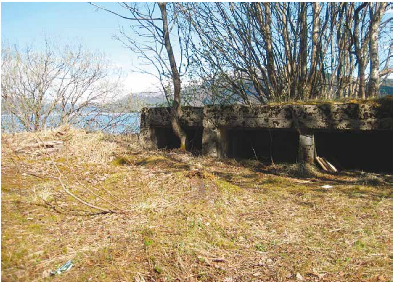
Ammunisjonsnisjer ved kanonstilling i Nes. Litt av dreieskiveringen i betong med metallskinne vises i forgrunnen. Metallskiva har innlagte gradtall. FOTO: TG.
