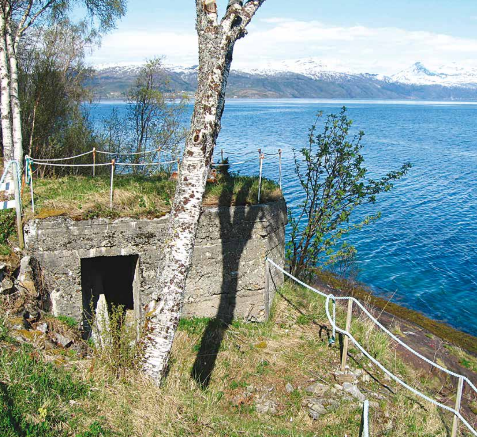
Rester av bunker i Nes. Foto: TG.
