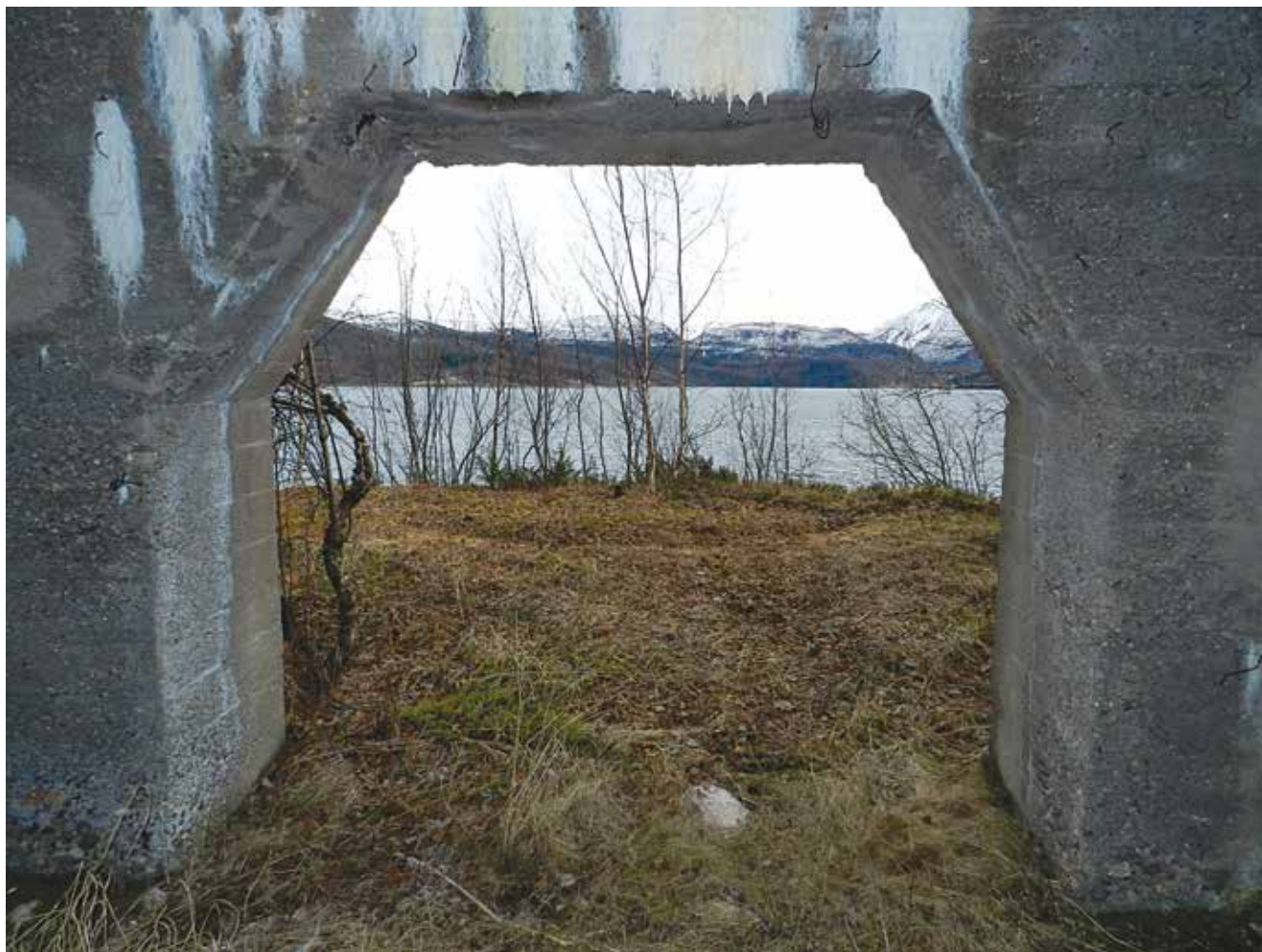
Kanonstilling for en mindre kanon, øst i Nes, utenfor tunnel. FOTO: TRUDE CECILIE GLEINSVÅG.
