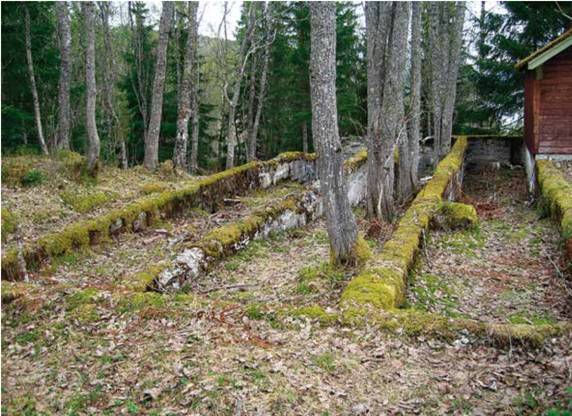
Rester av brakke- fundament på nedre side av Slettveien. Foto: TG.
