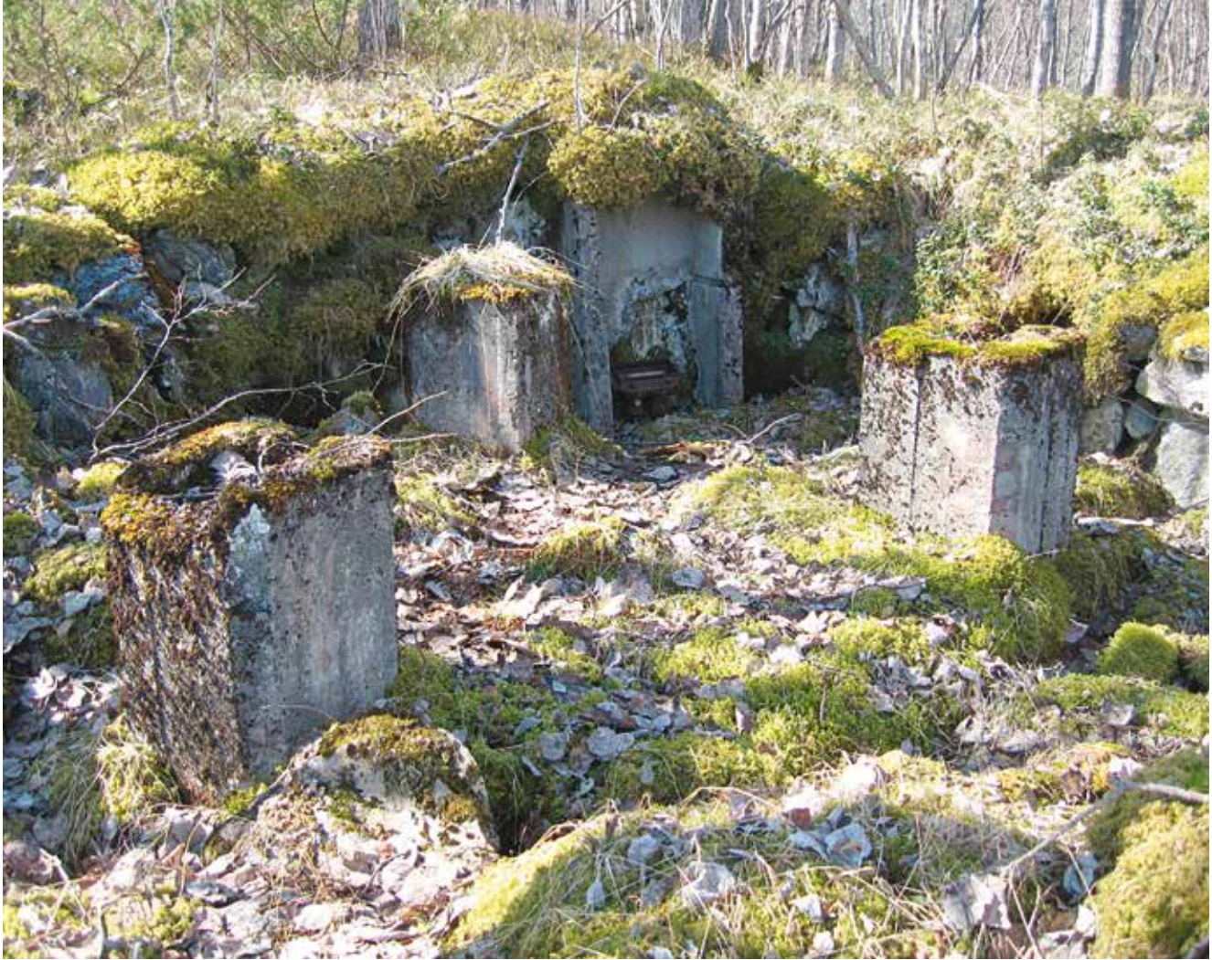
En av tre luftskyttsstillinger i nærheten av kommandobunkeren i Nes. I bakgrunnen kabelpunkt. Koordinater: N67°28.688' E015°28.453'. FOTO: TG..
