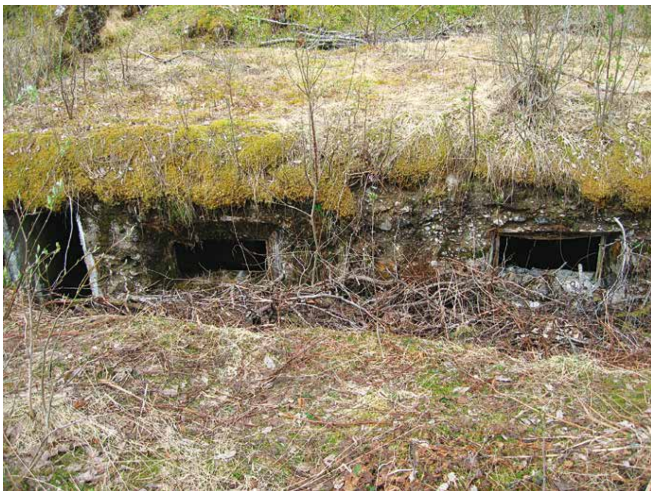
Beboelsesbunker i åsen nedenfor Slettveien/Brekkanveien like ved en maskingeværbunker. (s.5) Rester av kamouflasjenett. Løpegrav mellom bunkerne. FOTO: TG.
